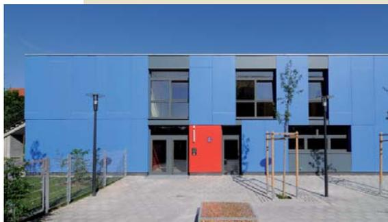
Der Kindergarten in der Truderinger Bajuwarenstraße wurde nach Stadtratsbeschluss im Passivhausstandard ausgeschrieben, d.h. sein Heizwärmebedarf darf nur 15 kWh pro m<sup>2</sup> und Jahr betragen. Bodenplatte und Dach werden außen mit über 30 cm PS - Wärmedämmung „eingepackt“. Alle Fenster und Verglasungen bestehen aus Dreifach-Isolierverglasung mit speziell passivhaus-zertifizierten Holz-Alu-Rahmen.
