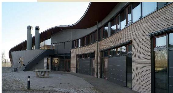
Mit der Montessori-Schule wurde 2005 in Aufkirchen die erste zertifizierte Passivhaus-Schule in Deutschland fertig gestellt. Hochwärmedämmung, kontrollierte Lüftung und Wärmerückgewinnung kennzeichnen die Haustechnik. Der ungewöhnliche Gebäudegrundriss ist in S-Form geschwungen und komplett mit einem Gründach überwölbt.
